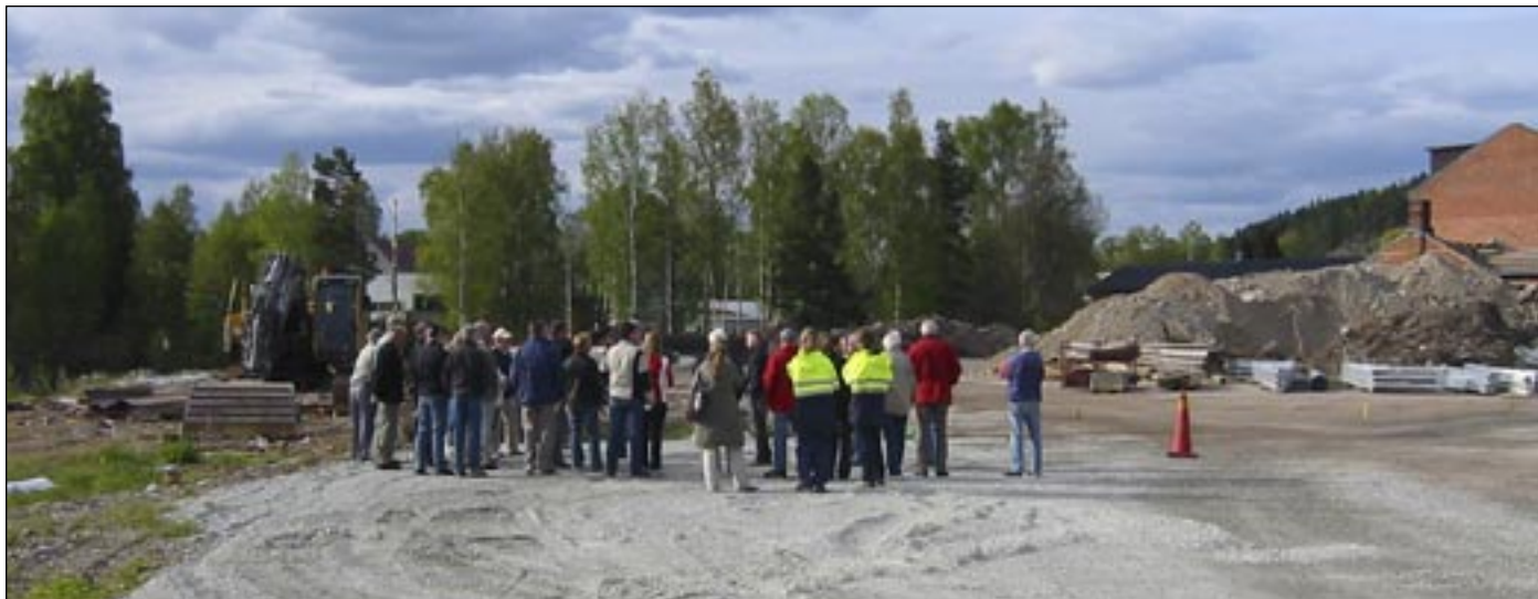
Rundvandring på EKA-tomten, Boh Tivesten, Bengtsfors kommun och Kjell Hansson, Empirikon AB berättar om de pågående och kommande entreprenadarbetena. Foto: Johan Fogelström
