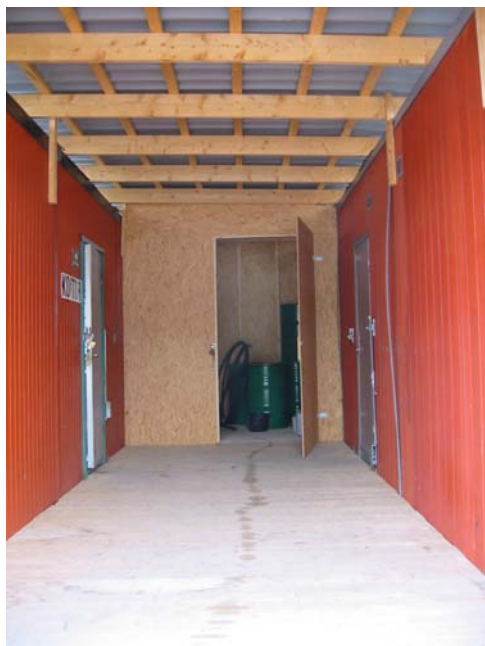
I låst utrymme vid arbetsbodarna förvaras rester från provtagning i tunnor för förorenat vatten, jord och övrigt förorenat fram tills borttransporten till SAKAB.
