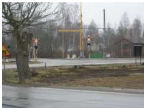
Gamla Bruksgatan vid järnvägsövergången
