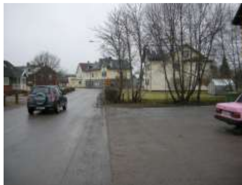
Byggnader mot Gamla Bruksgatan
