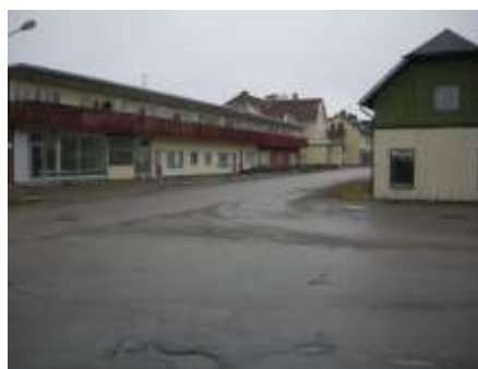
Loftgångsbyggnaden vid korsningen Gamla Bruksgatan – Gamla Postgatan
