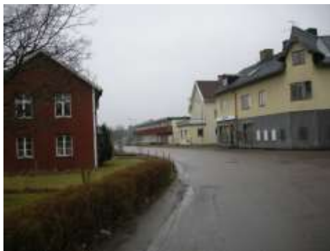
Byggnader mot Gamla Bruksgatan
