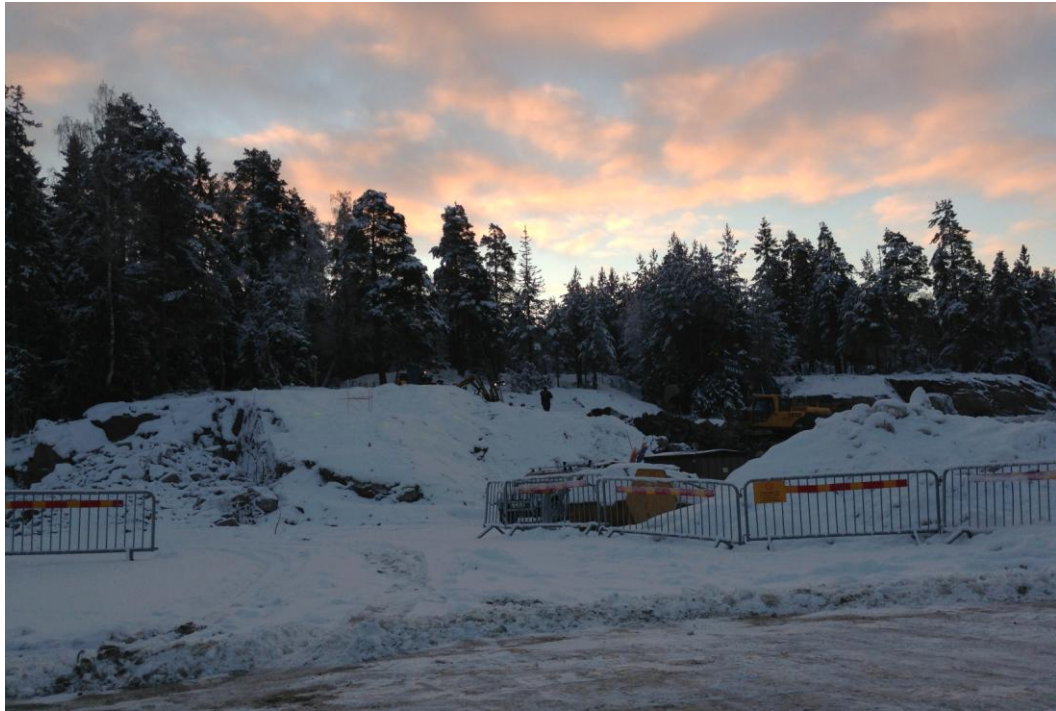
Sprängningsarbeten i södra delen av planområdet januari 2013.
