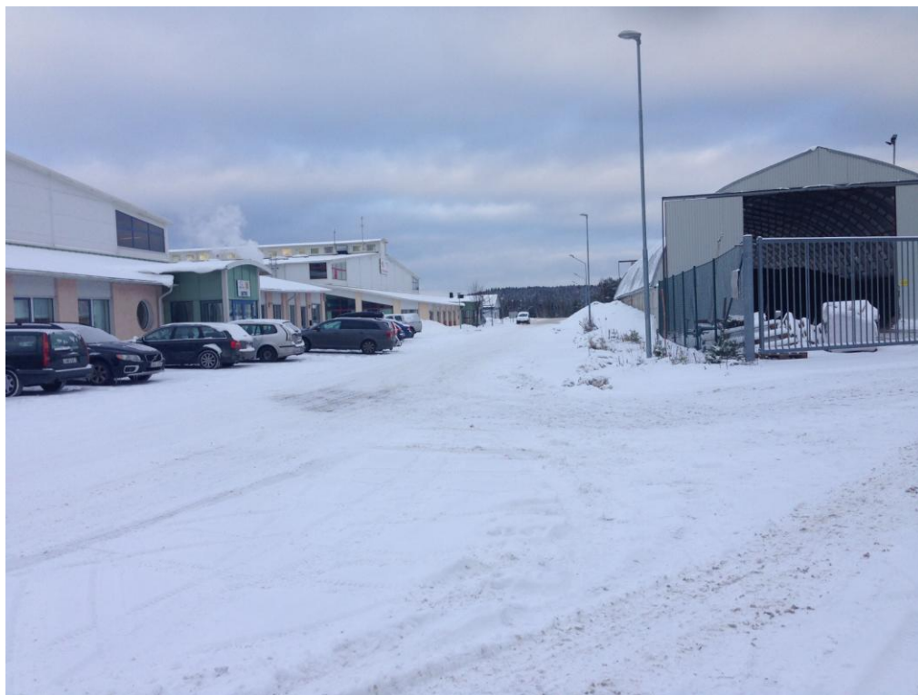
Befintlig industri, foto taget mot norr.
