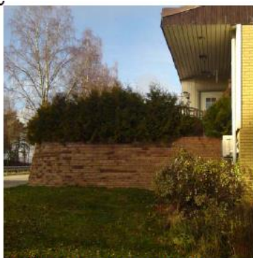
Stödmur mot Enetsvägen
