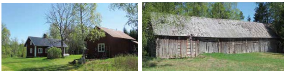
Bilder på Björke från kulturhistoriska byggnadsinventering (2019).
