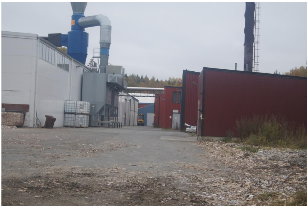
Fabriksområdets södra del. Industrins interna reningsverk till höger i bild.
